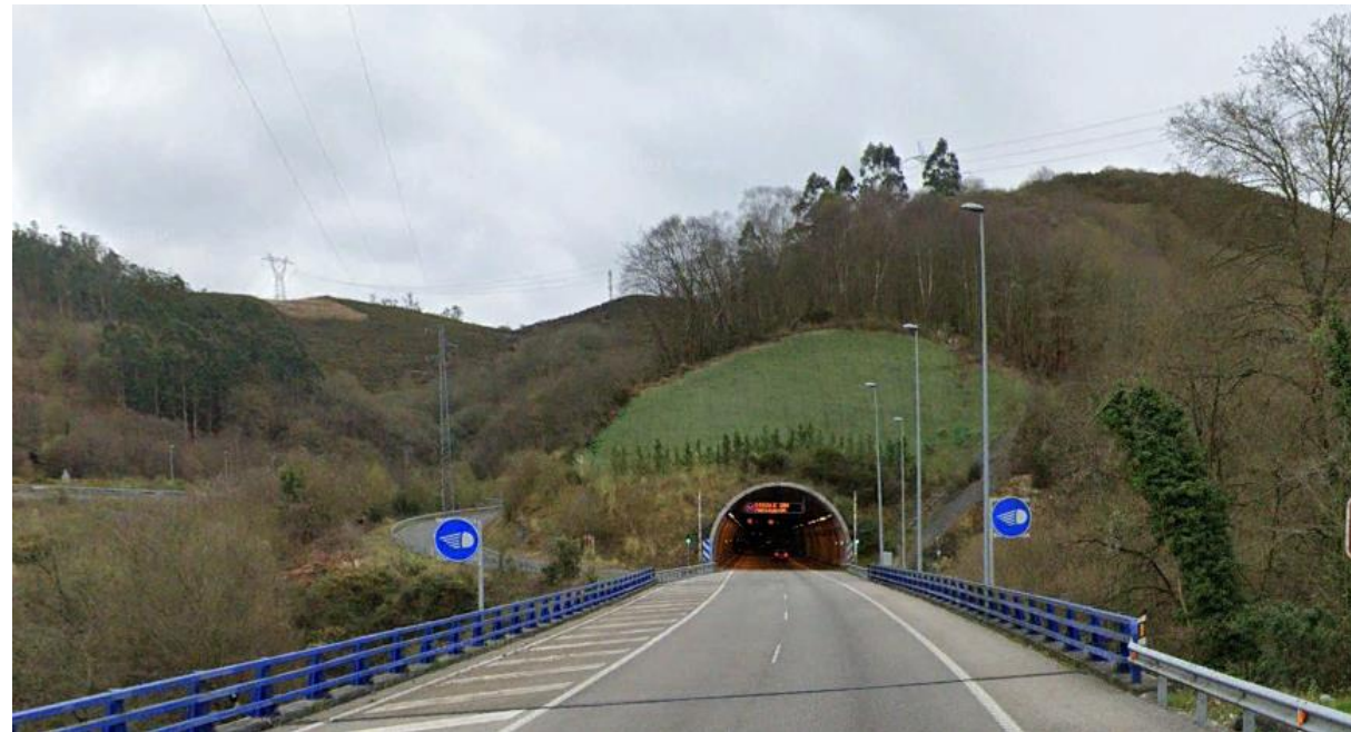
Figura 4. Vista de uno de los túneles de la UME AS-17
