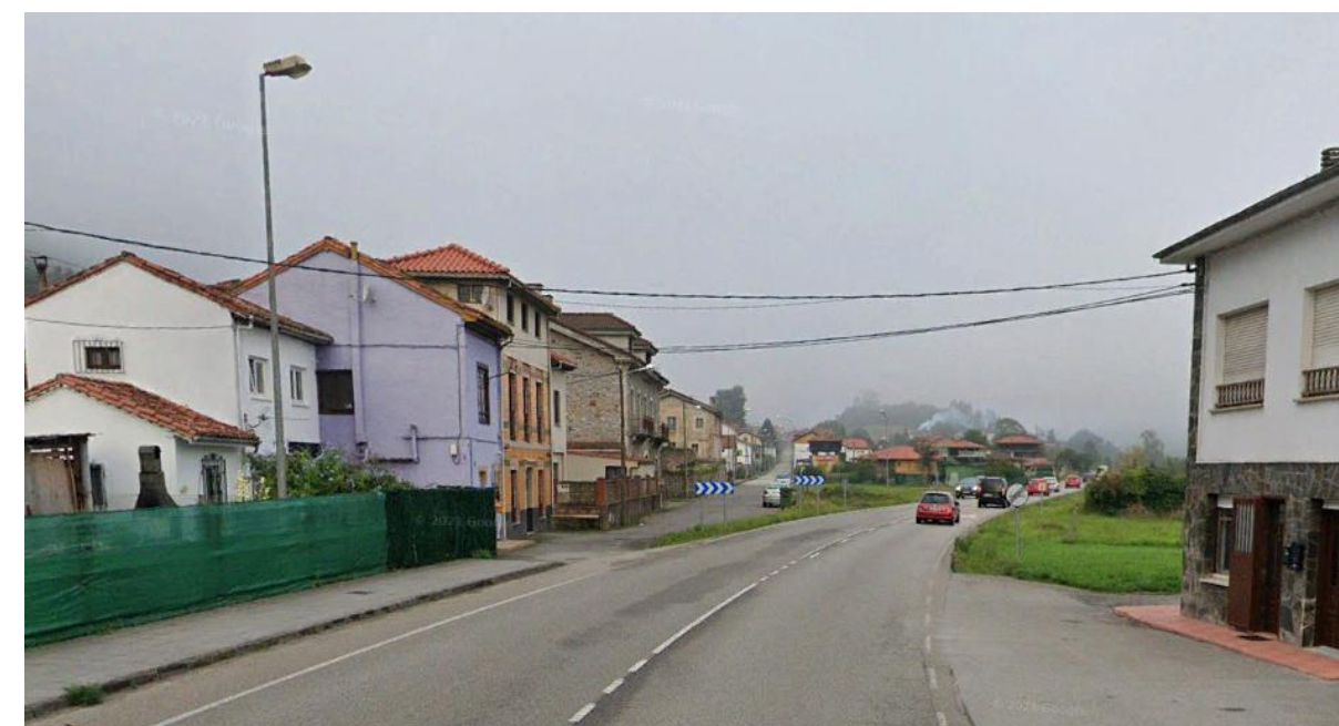
Figura 3. Vista de la AS-16 a su paso por Peñauillán
