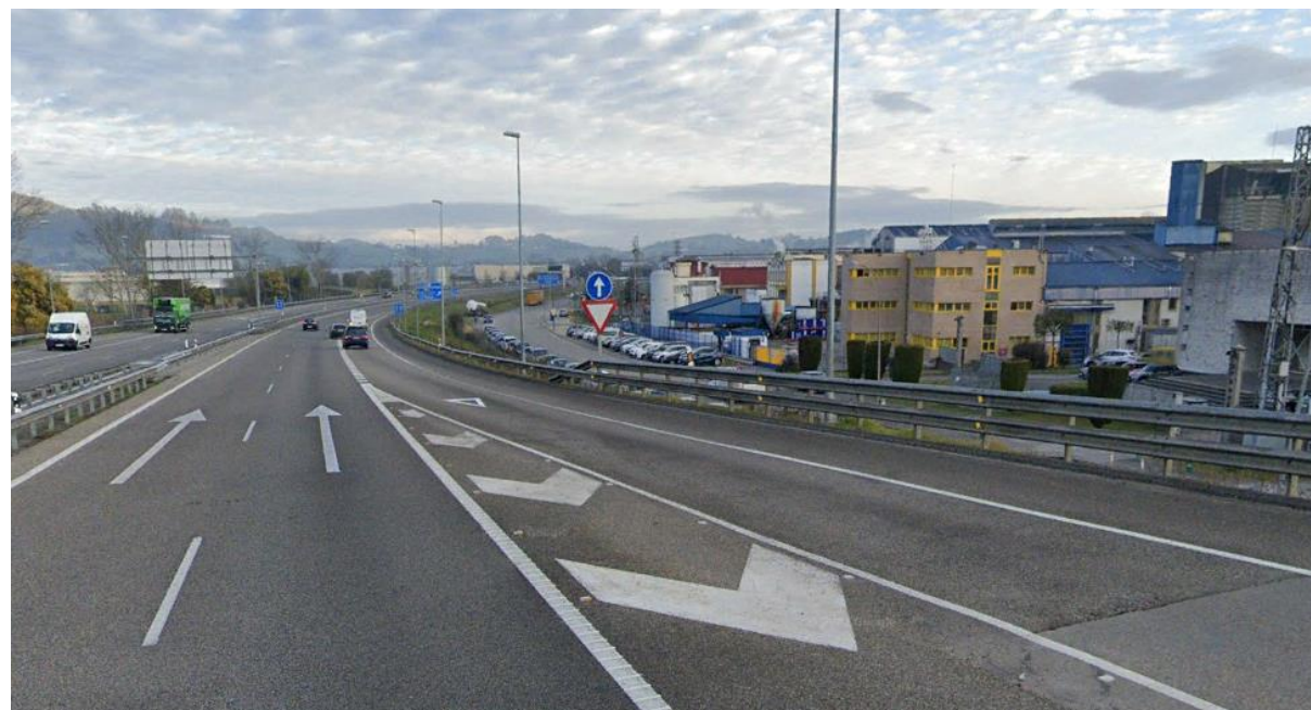
Figura 2. Vista de la AS-II a su paso por el Polígono de Silvota
