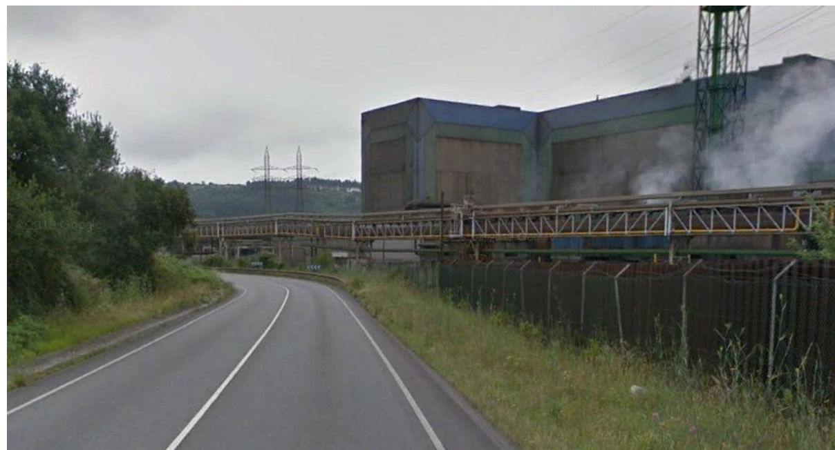
Figura 6. Vista de la AS-110 atravesando una zona industrial
