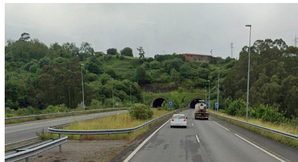
Figura 1. Vista desde la AS-I a la entrada de uno de sus túneles
