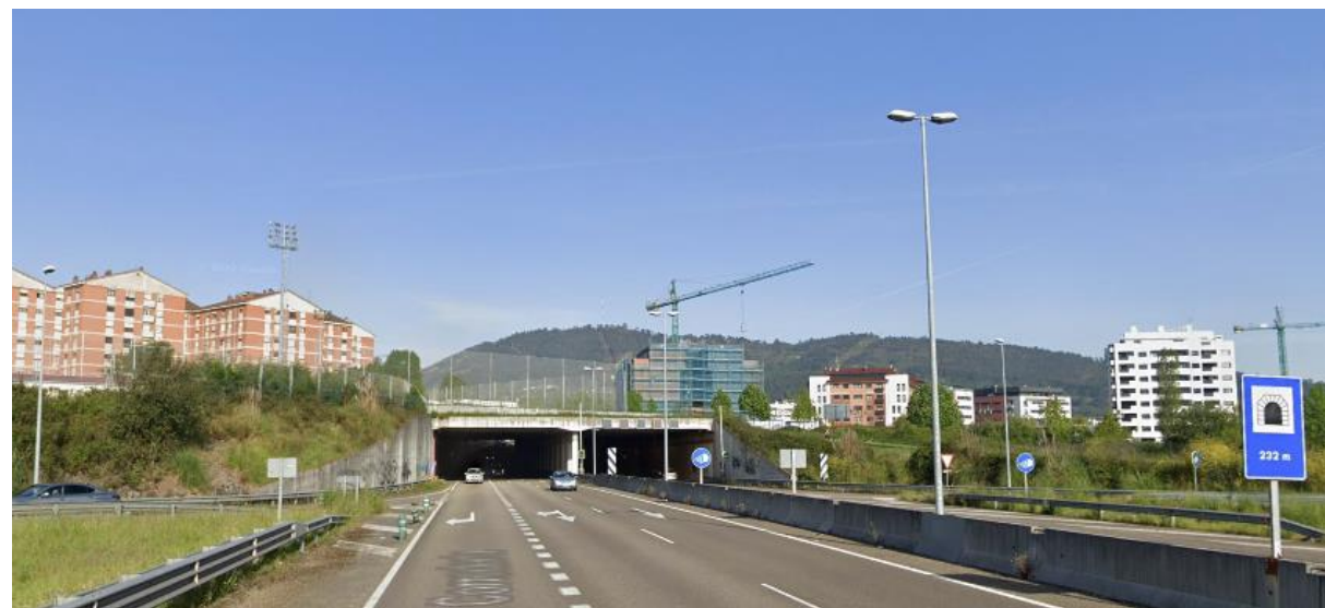
Figura 14. Imagen de la entrada al túnel de la UME AS-390
