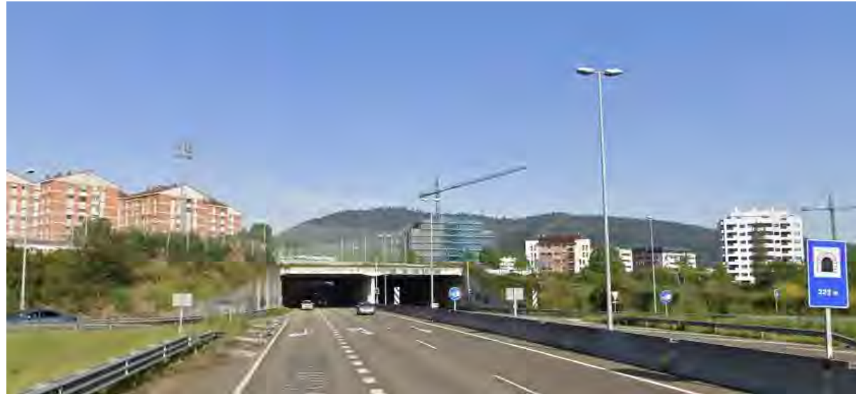
Figura 9. Imagen de la entrada al túnel de la UME AS-390
